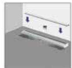
**8.** Extiende la mezcla de concreto hasta llegar al borde superior del desagüe considerando el espesor del revestimiento a utilizar y dejando una inclinación como mínimo de 2% por metro lineal, en dirección a donde se instalará. Si lo deseas, instala una membrana impermeabilizante siguiendo las instrucciones del fabricante.
