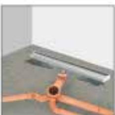
**6.** Vierte la mezcla del mortero en la parte inferior de la base del desagüe para dar soporte y fijar la nivelación.
